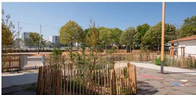
> 90 % de la cour a été désimperméabilisée afin de permettre l'infiltration des eaux de pluie
